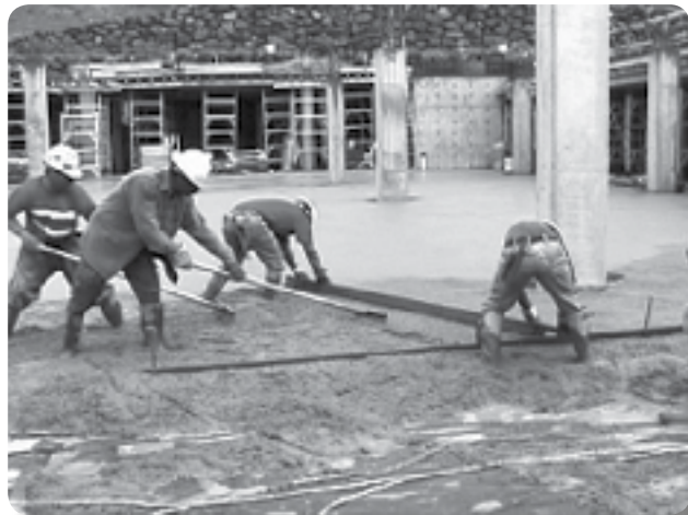
Problema: Uso de una niveladora manual
