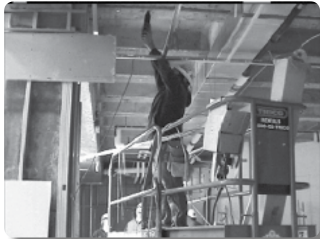
Problema: Taladrar en sitios que requieren movimientos por encima de la cabeza
