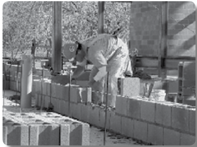
Problema: Instalación de bloques de concreto estándar
