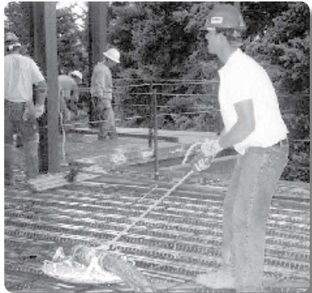
Solución: Halar la manguera con una base y gacho para deslizar
