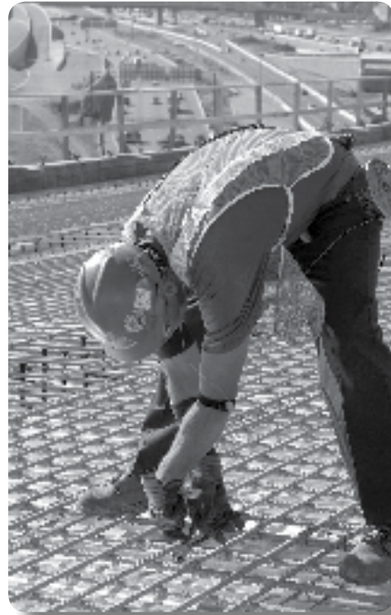
Solución: Herramienta para atar barras de refuerzo con mango de extensión
