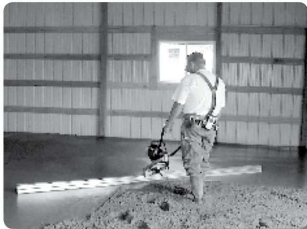
Solución: Uso de una niveladora motorizada
