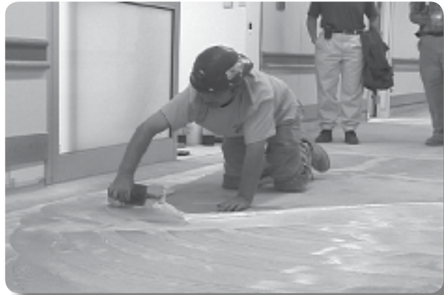
Problema: Arrodillarse para trabajar cerca del piso
